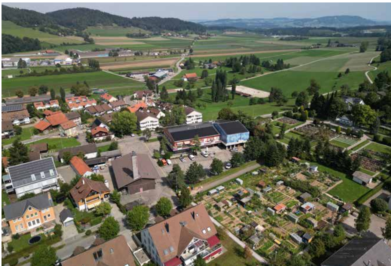
Das Werkgebäude mit der neuen Indach-Photovoltaikanlage.
