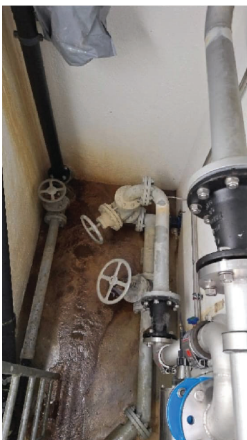
Bild 8: Rohrkeller auf Seite Quelleinlauf
