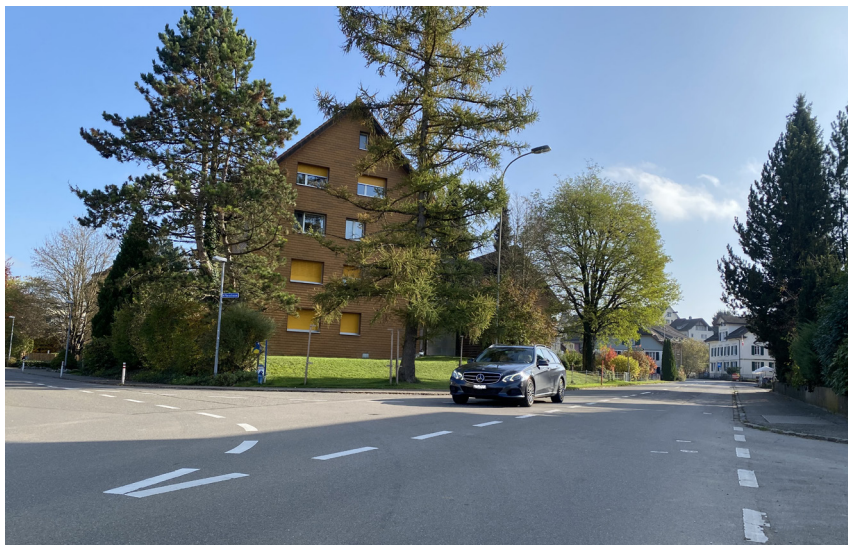
Ab der Kreuzung mit der Florastrasse wird die Winterthurerstrasse durch den Kanton saniert und für Tempo 30 fit gemacht. Bilder: Markus Koch
