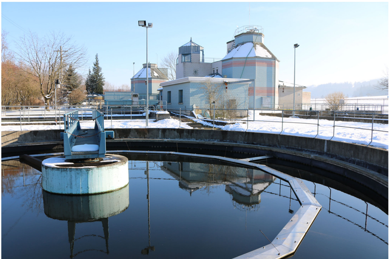
ARA Püntacker: Nachklärbecken mit Betriebsgebäude im Hintergrund
