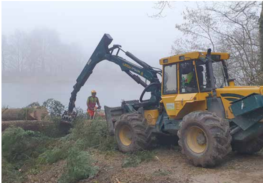
Der Gemeinderat genehmigte den Kredit für die Dammsanierung am Heurütiweiher.
